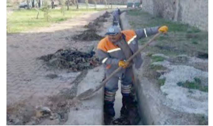
Sulama Suyu Kanalının Temizliğini Yapmak
