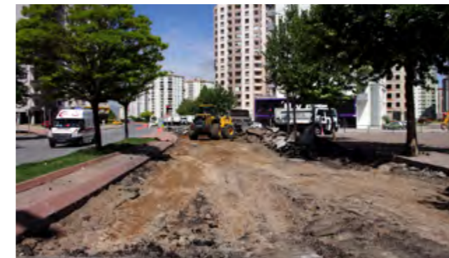
Mevlana mahallesi Mehmet Timuçin Caddesi yol altyapı çalışması.
