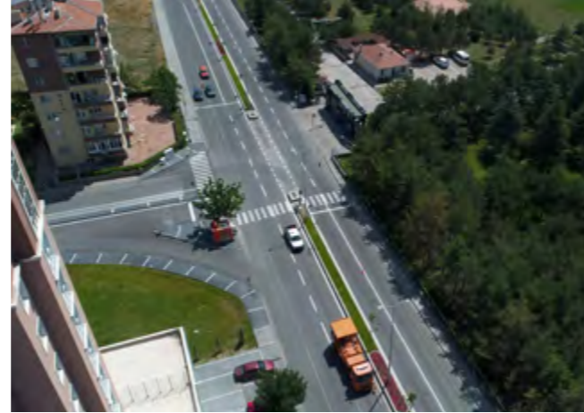
Yol çizgi boyanması uygulaması.
