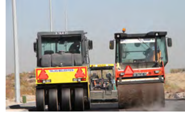
Mevlana mahallesi Mehmet Timuçin Caddesi asfalt serim çalışması
