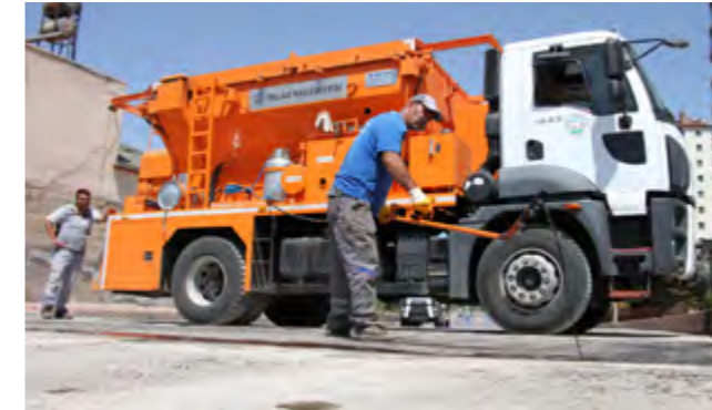
Harman Mahallesi Şehit Komandolar Caddesi asfalt yama çalışması
