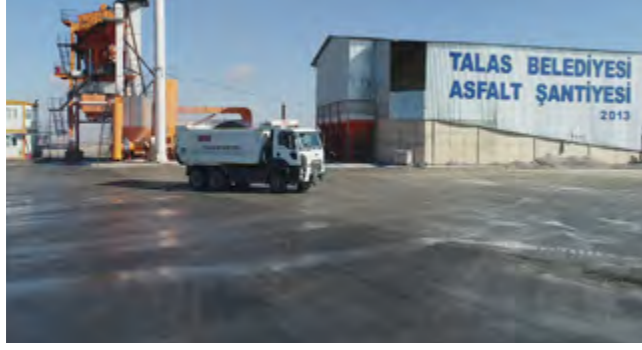
Talas Belediyesi Asfalt Planti
