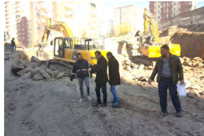
Mevlana mahallesi Hidayet Aydoğan okulu yanı anaokulu temel açımı aplikasyon ve kot kontrol çalışması.
