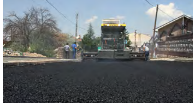
Yukarı mahalle köprüsü sokak asfalt serim çalışması
