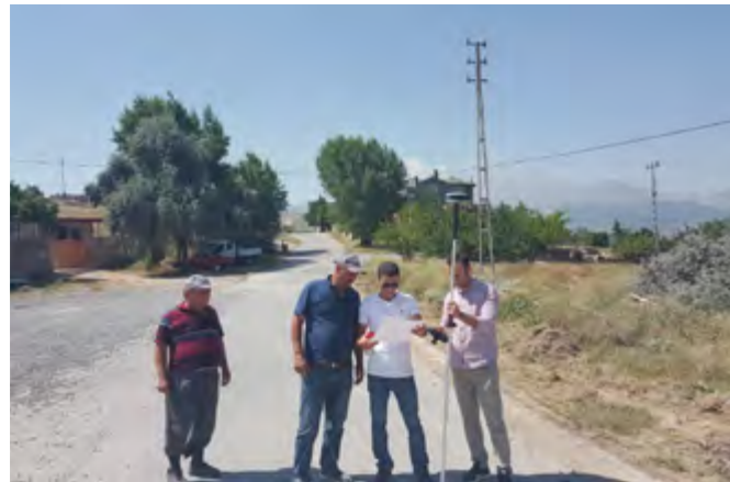
Reşadiye mahallesi Mehmet Akif 1 Caddesi yol sınır aplikasyon çalışması.
