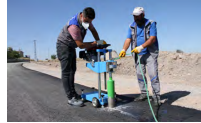
Reşadiye mahallesi Mehmet Akif 1 Caddesi asfalt numune alınması.
