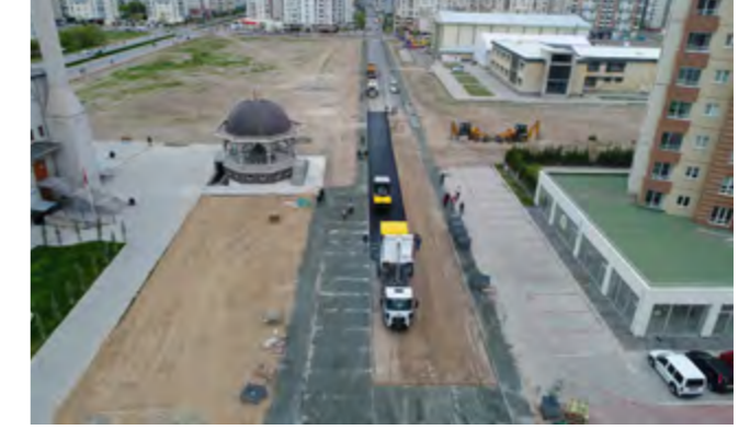
Mevlana mahallesi Metehan Sokak asfalt serim çalışması.
