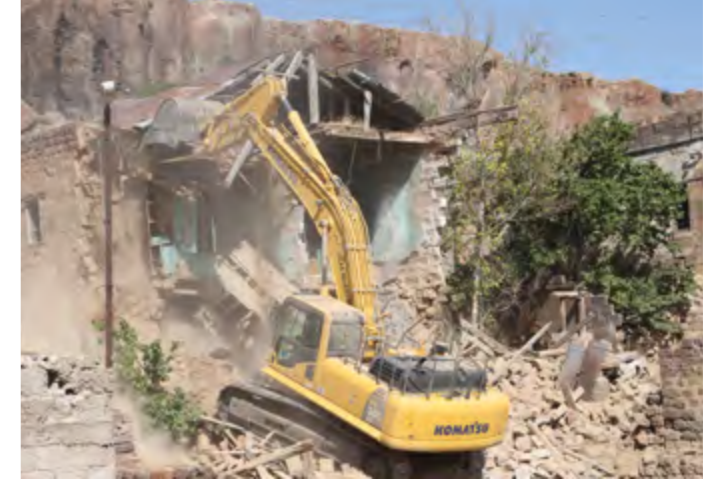
Başakpınar mahallesi tehlike arz eden evlerin yıkım çalışması.
