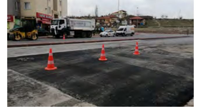
Mevlana mahallesi Papatya Caddesi asfalt yama çalışması.
