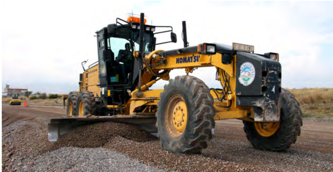
Cebir – Örencik – Yazırdu kavşağı yol kotu düzenleme çalışması.
