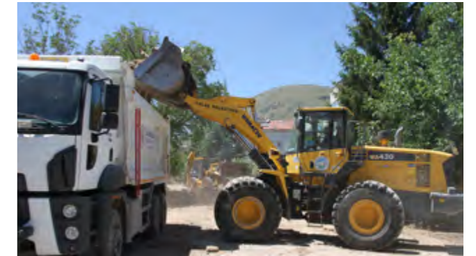
Yukarı mahalle köprüsü sokak yol altyapı çalışması.
