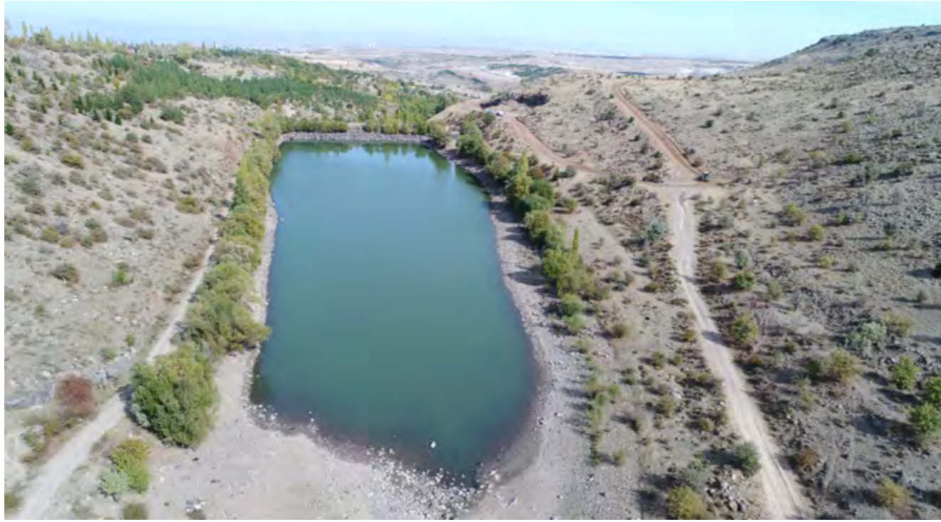
Zincidere mahallesi gölet yolu yol altyapı çalışması.
