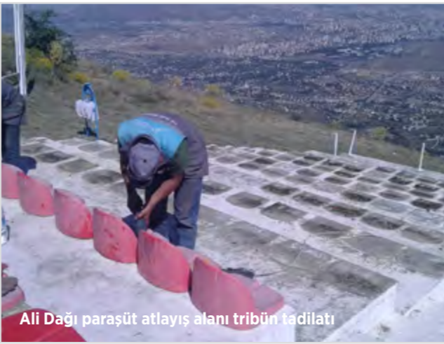
Kuruköprü Futbol Sahası Tribün Tadilatı
