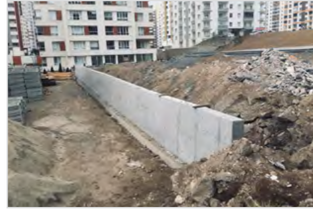
Hacı Ali Sokak Duvar Yapımı
