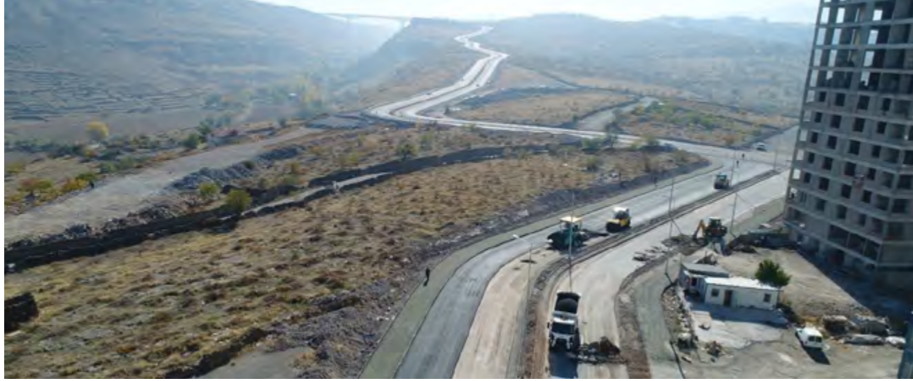
Mevlana mahallesi Mehmet Timuçin Caddesi asfalt serim çalışması.
