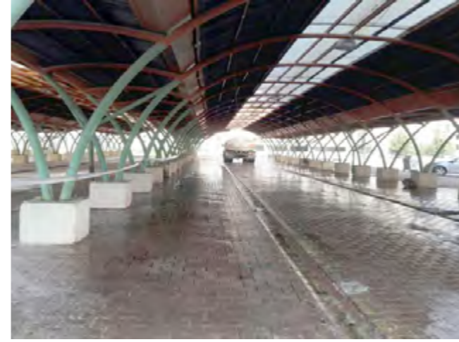
İlçemiz Sınırlarındaki Pazar Yerlerinin Yıkınması ve Temizlenmesi
