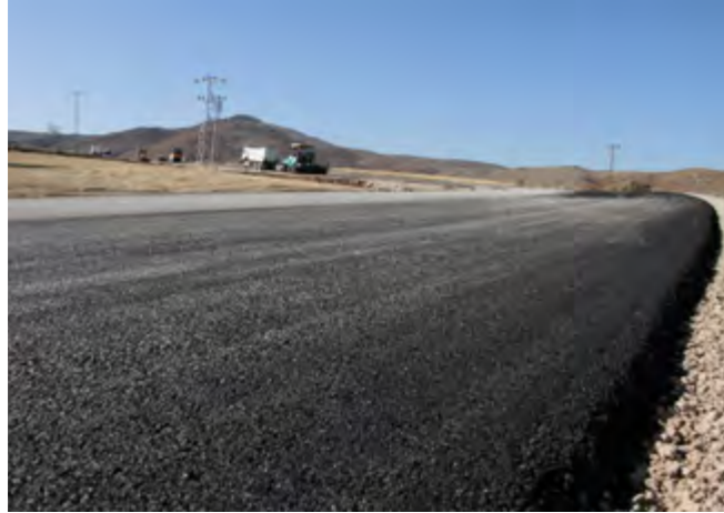
Cebir – Örencik – Yazırdu kavşağı asfalt serim çalışması.
