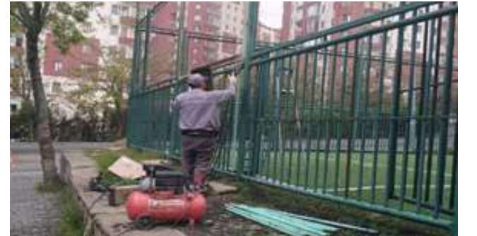
Spor Parkları Demir Korumalık Onarım
