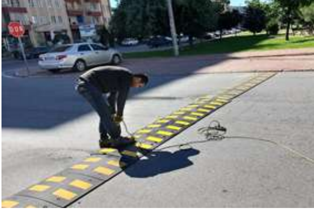
Hız Kesici Bariyerleri Onarım ve Montaj İşleri
