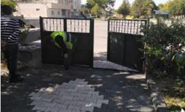
Demir Kapı Yapım ve Onarım İşleri
