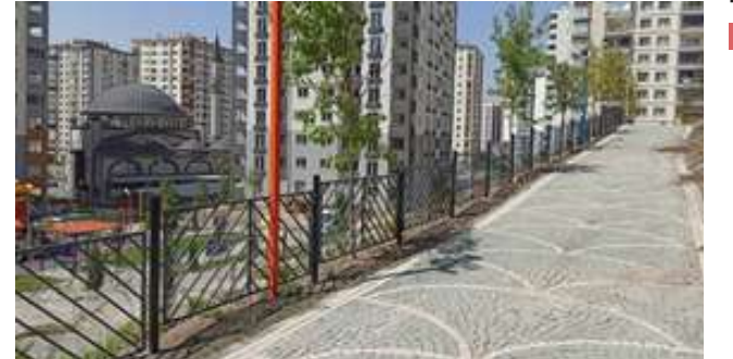
Parklarda Demir Korkuluk Yapım ve Onarım
